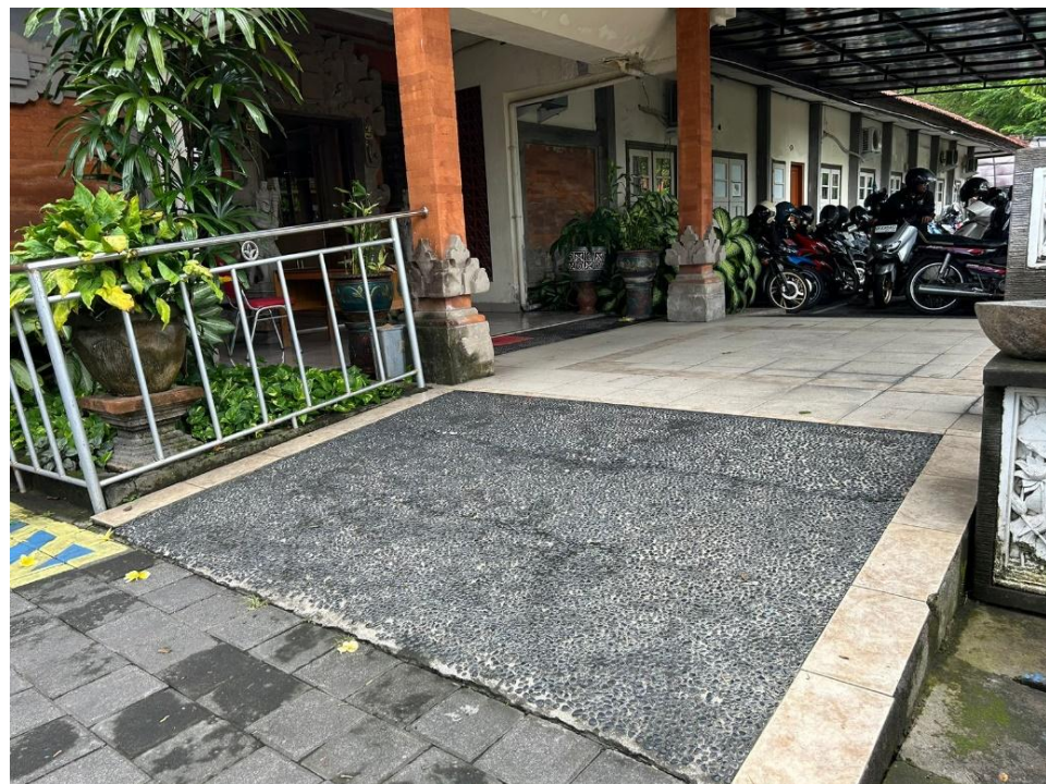
Gambar 2. 3 Jalan landai ( ramp )
